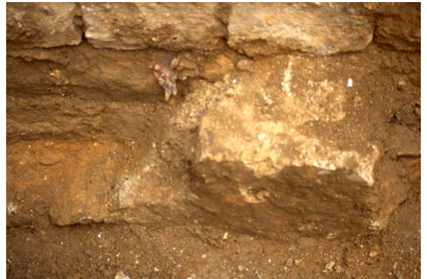
FOTO 2. Fonamentació de la paret mitgera amb l'immoble núm. 7
