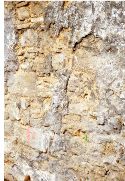
FOTO 4. Parament de la paret mitgera amb l'immoble núm. 7
